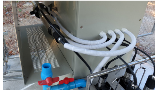
Ein Spektralsensor mit Durchflussarmatur sowie zusätzlicher Druckluftreinigung, installiert auf der Rückseite der Messstation.
