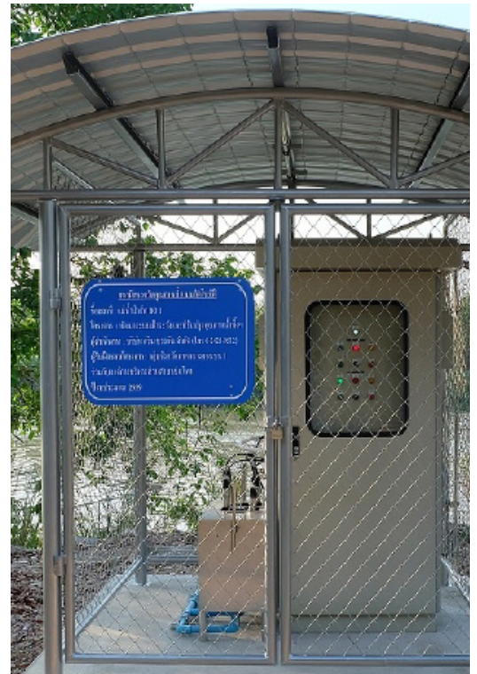
Eine der sechzehn neu installierten Flusswassermessstationen im Großraum Bangkok. Sie ist zur Vorbeugung gegen Vandalismus und Entwendung von Messgeräten eingehaust.
