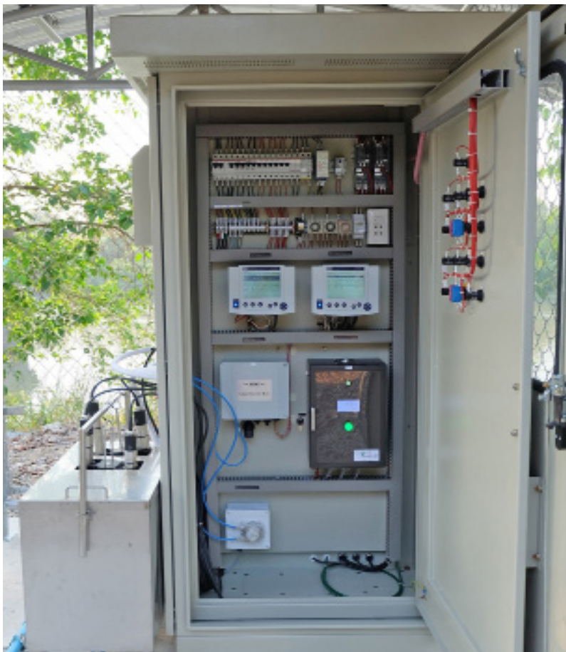
Das Innere der Messstation mit IQ-Controllern, Cleaning Air Box für die zusätzliche Druckluftreinigung des Spektralsensors, sowie Modem zur Datenfernübertragung. Links daneben ist das Durchflussbecken mit installierten Sauerstoff-, pH-, Leitfähigkeits- sowie Trübungssensoren zu sehen.
